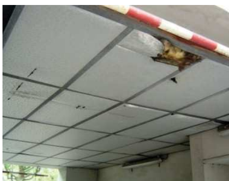
Isolation sous toiture
