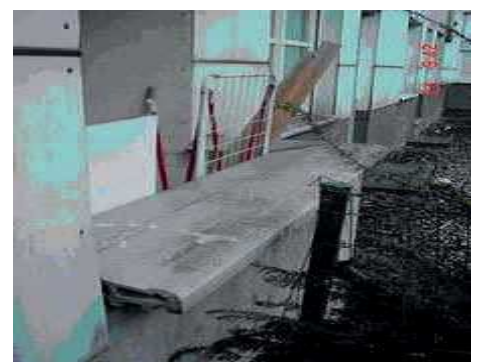
Appuis de fenêtres
