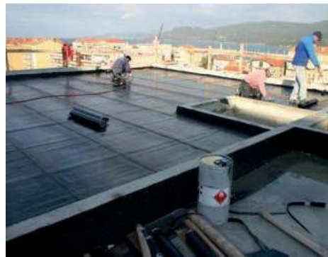
Étanchéité bitumineuse
