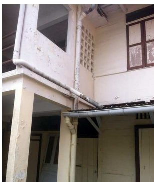
Descente eaux pluviales
